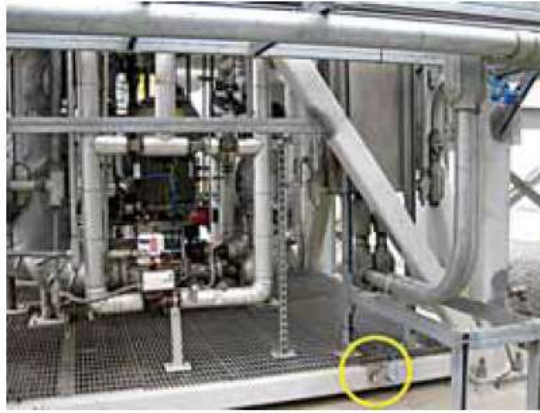
Рис. 1. Закріплений п'єзодатчик вібрації Volture на коливній платформі [1]
