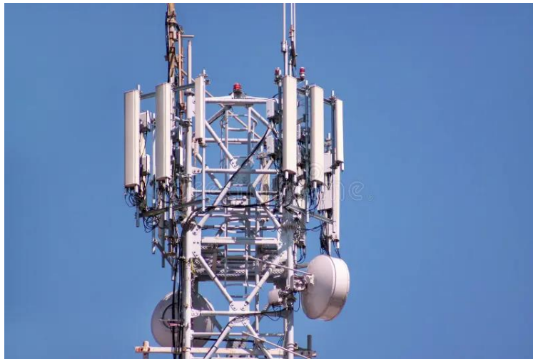
Рис. 1. Ретранслятори телекомунікаційної мережі, базова приймально-передавальна станція, яка містить баштовий передавач та ретранслятор антени бездротового зв'язку Джерело: сформовано авторами
